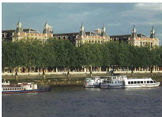
写真-1 テムズ河添いの聖トマス病院・南病棟 (金井一薫撮影)
